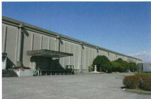
岐阜県で唯一の丹下作品である艶金興業岐阜工場は、東京オリンピック開催前の昭和39年5月に竣工した。大型クレーンの出現で可能となった、プレキャスト・コンクリート工法で造られた。完成時は戦艦大和と同じ長さだったというが、現在は少し短くなり貸倉庫として利用されている。
